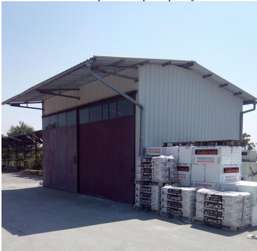
POMOĆNA HALA C - sjeverno i zapadno pročelje
