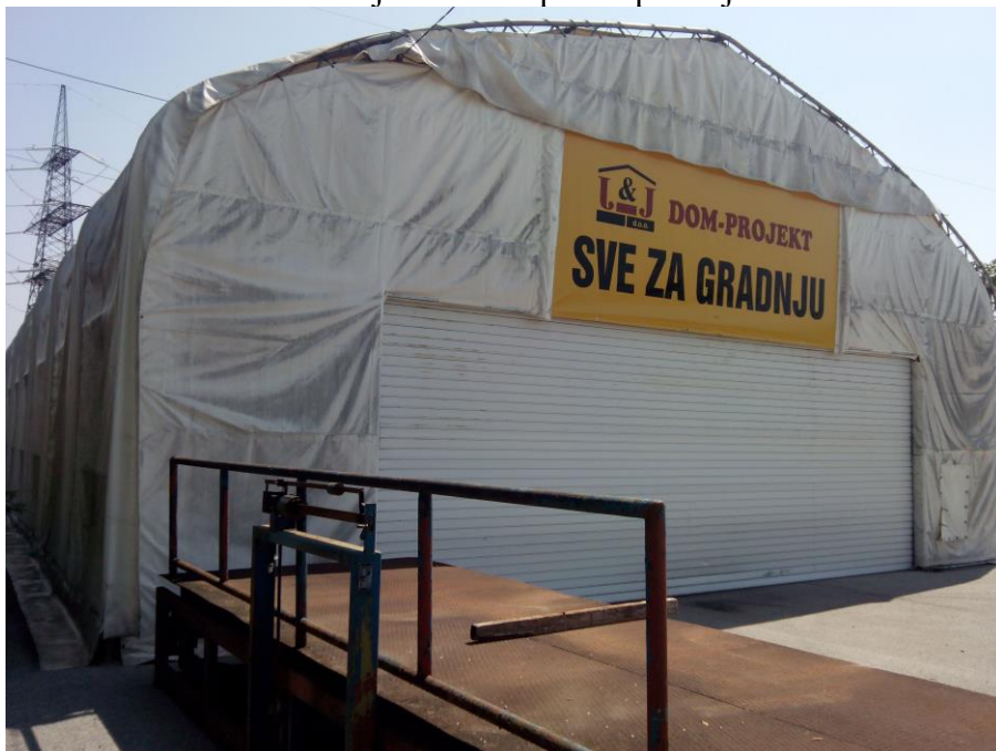
POMOĆNA HALA D – sjeverno i zapadno pročelje
