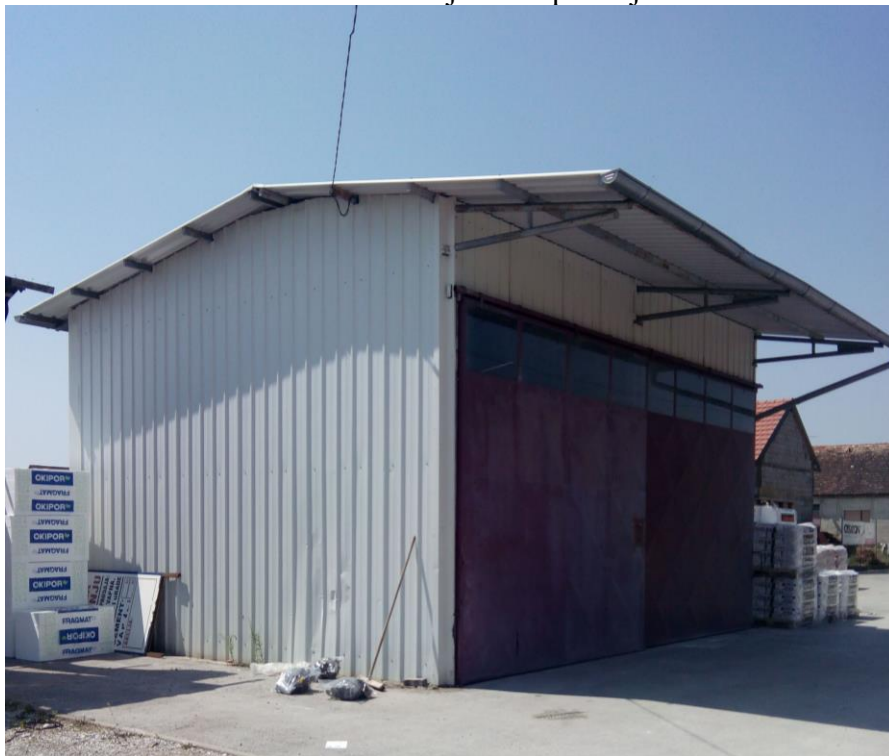
POMOĆNA HALA C - istočno i sjeverno pročelje
